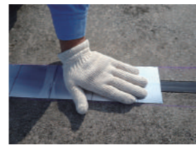
VGメジパスを伸縮目地をまたぐように施工します。
